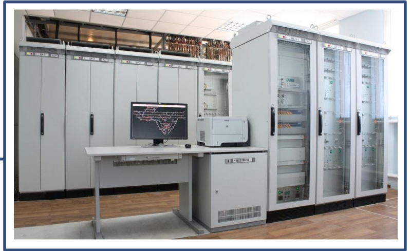
Розміщення обладнання МПЦ-У в релейному приміщенні поста ЕЦ
